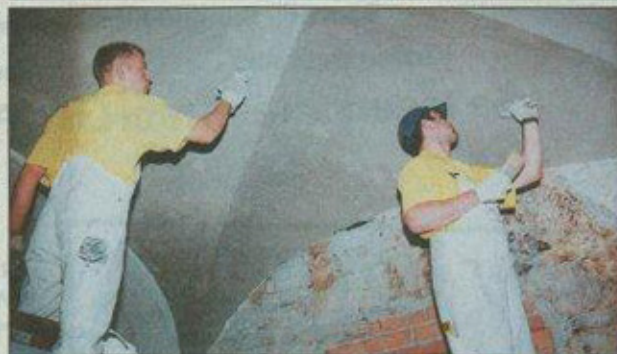
Tino Katzschmann und Marco Peim von der Firma Malermeister Hofmann aus Zschoppelshain verputzen zur Zeit das rustikale Kreuzgewölbe im Klosterkeller des Benediktinerklosters in Wechselburg. Nach erfolgter Sanierung soll das Gebäude als Erweiterung des Jugend- und Familienhauses dienen. Fotos (2): Rico Lippmann
